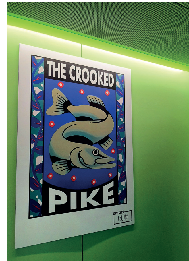
Bandeaux LED au plafond
